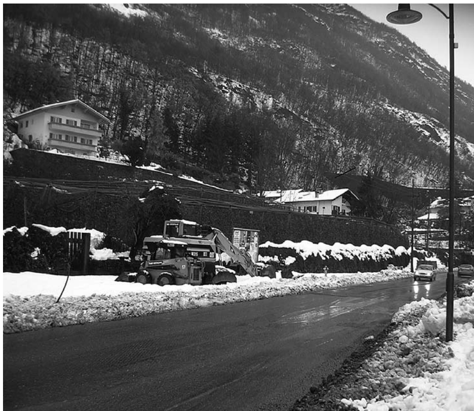
Collaudo statico per il ridimensionamento della strada Der Rückbau der Staatsstraße schreitet voran
