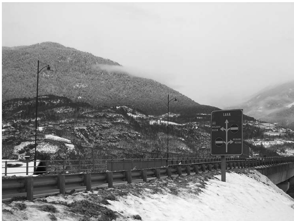
Die neue Straßenbeleuchtung auf der Etschbrücke Lampioni sul ponte per Lana
